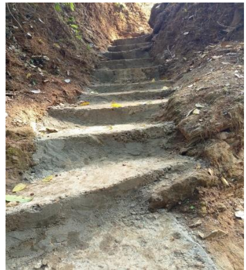
घिमिरे टोल जाने बाटो निर्माण वडा नं ६
