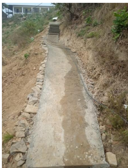
महेन्द्र मा.वि स्कूल जाने गोरेटो बाटो निर्माण वडा नं - ३
