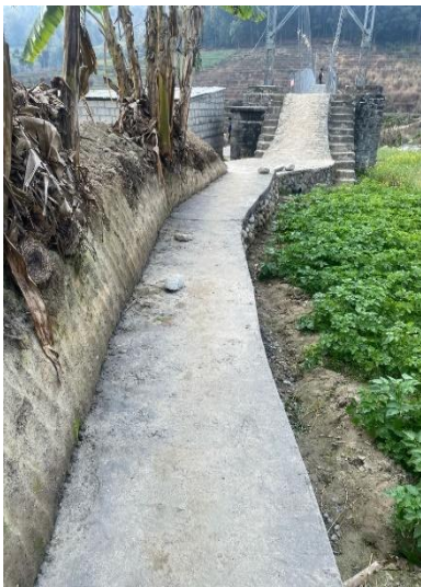
बेलखु खोला झोलुङ्गेपुल निर मोटर बाटो निर्माण वडा नं -८
