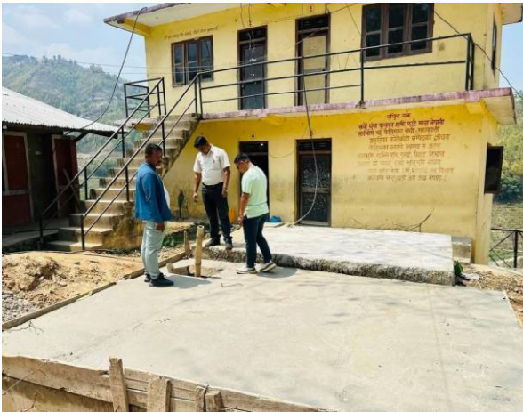
किराञ्चोक मा.वि. को निर्माणाधीन आवासीय विद्यालय भवन अनुगमन
